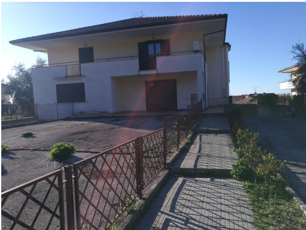
Foto n°1 : Vista Esterna Ingresso P.Ila 5283
