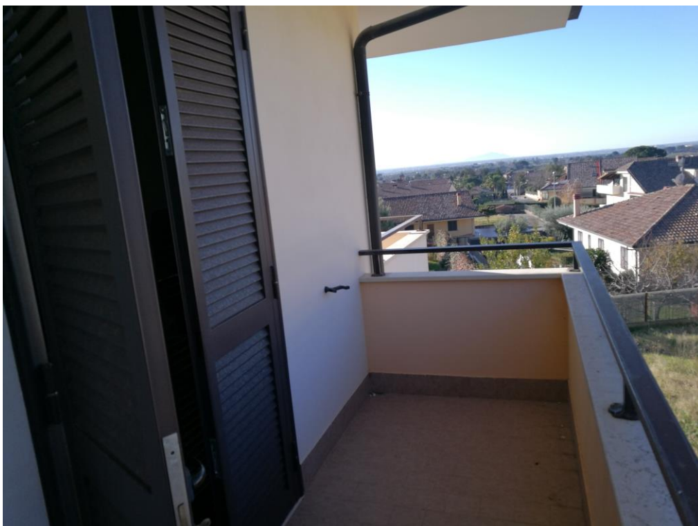
Foto n°6 : Vista Esterna Balcone Lato Nord-Ovest – P.Ila 5283 sub 6
